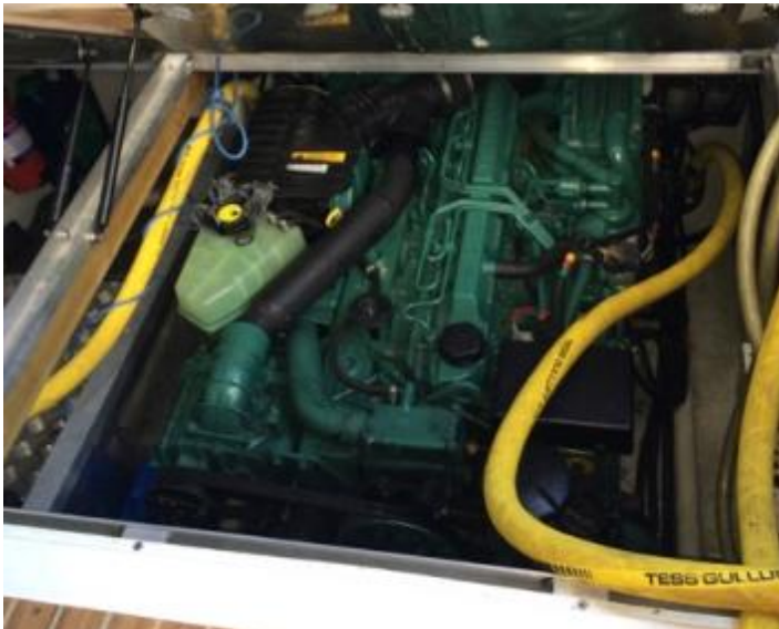
Circulación con bomba de achique.
